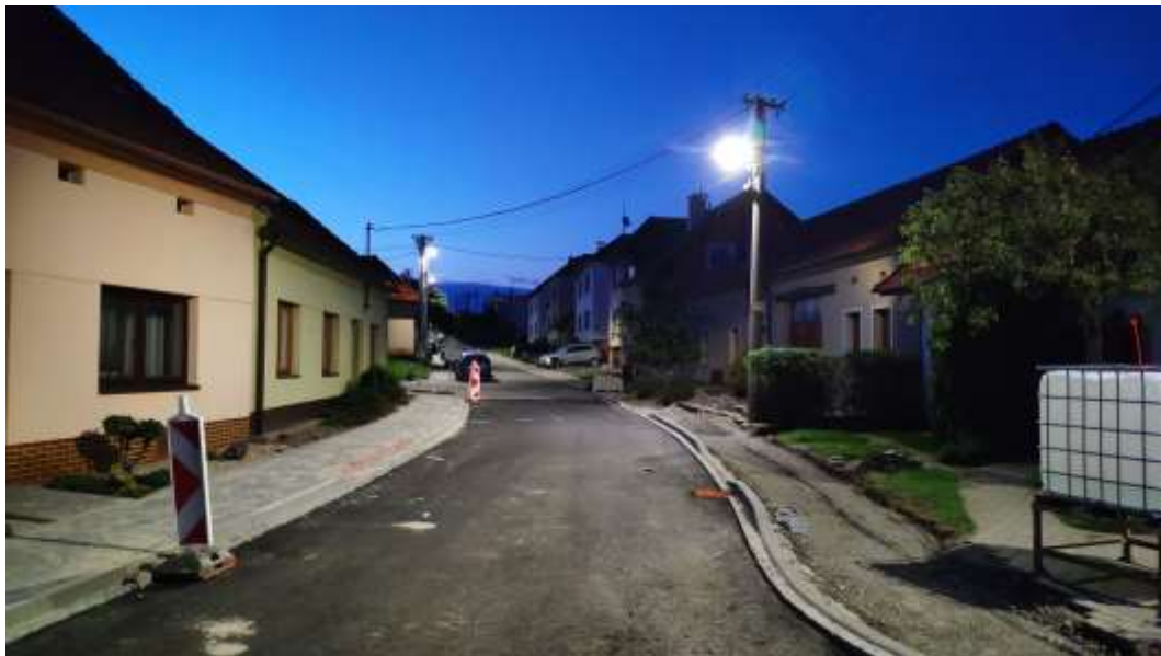
Obr. 123: Charakter VO v ulici Pod Lipkami - svítidla jsou osazená na výložnicích ze stožárů energetických rozvodů. Použití LED zdrojů – viditelné kvalitní podání barev.
