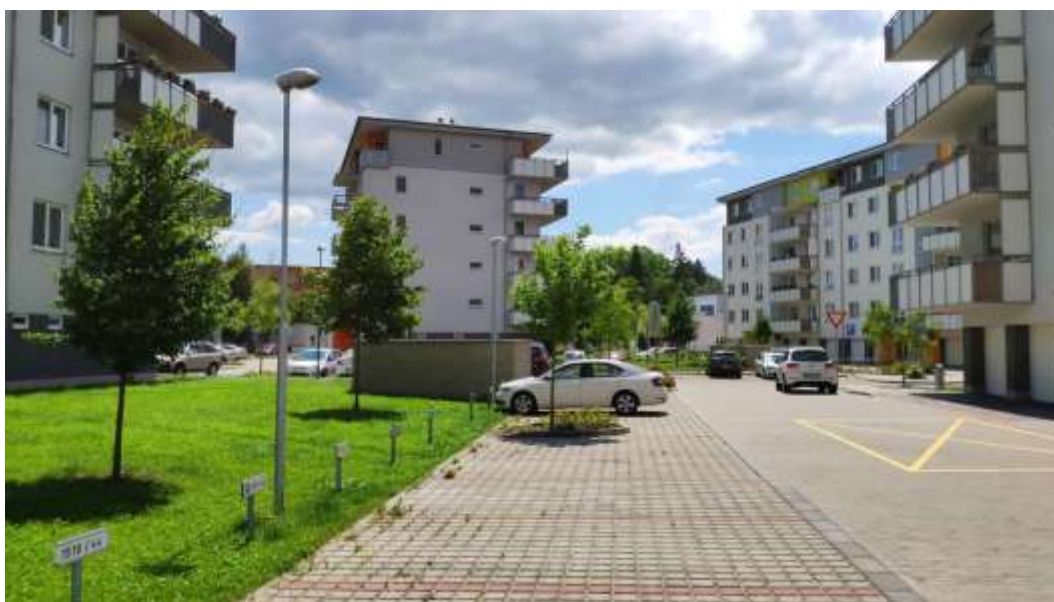
Obr. 97: Charakter VO na sídlišti Štěpnice v ulici Zahradky – svítidla na odstupňovaných stožárech, bez patice.
