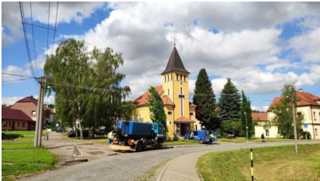
Obr. 115: Veřejné osvětlení centrálního veřejného prostoru Jarošova jako součást energetických rozvodů. Svítidla jsou osazená na výložnicích ze stožárů energetických rozvodů.
