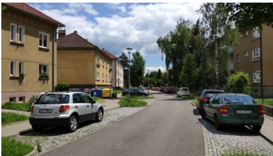
Obr. 95: Charakter VO na sídlišti Mojmír I v ulici Jana Žižky - svítidla na kónických stožárech, bez patice, designové svítidlo.
