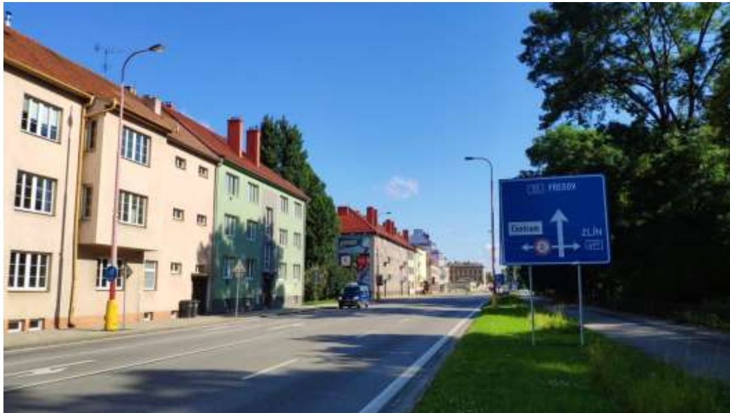
Obr. 88: Charakter VO na třídě maršála Malinovského (silnice I/55) - světelné zdroje na vysokých stožárech s nástavcem. Svítidlo a stožár bez důrazu na design.
