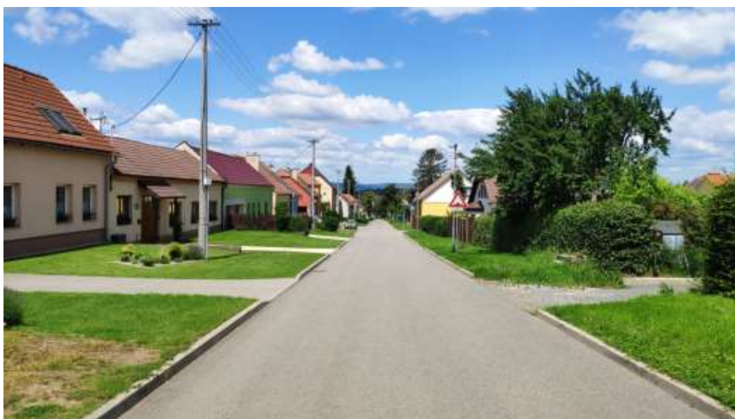
Obr. 131: Charakter VO v ulicích s obytnou zástavbou – svítidla technického typu na odstupňovaných stožárech, svítidlo bez důrazu na design.
