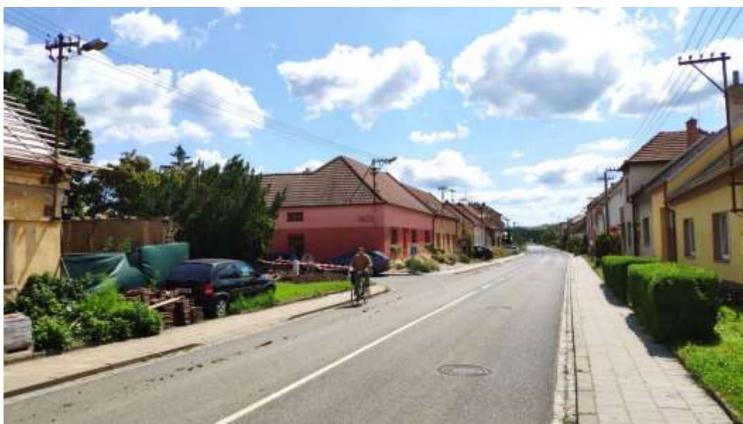
Obr. 121: Charakter VO v ulici Solná cesta - svítidla jsou osazená na výložnicích ze stožárů energetických rozvodů kotvených na fasádách objektů.
