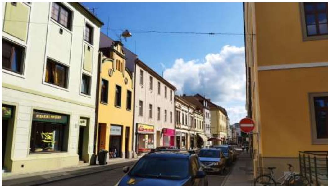
Obr. 78: Veřejné osvětlení na převěsech v Nádražní ulici. Různé typy svítidel, nepravidelné rozmístění.
