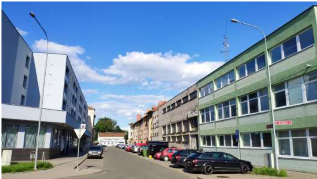
Obr. 87: Charakter VO v Dvořákově ulici - světelné zdroje na vysokých stožárech s nástavcem. V ulicích mimo základní komunikační systém města by bylo vhodné zvážit snížení výšky svítidel, pokud to prostorové podmínky v ulici umožňují.
