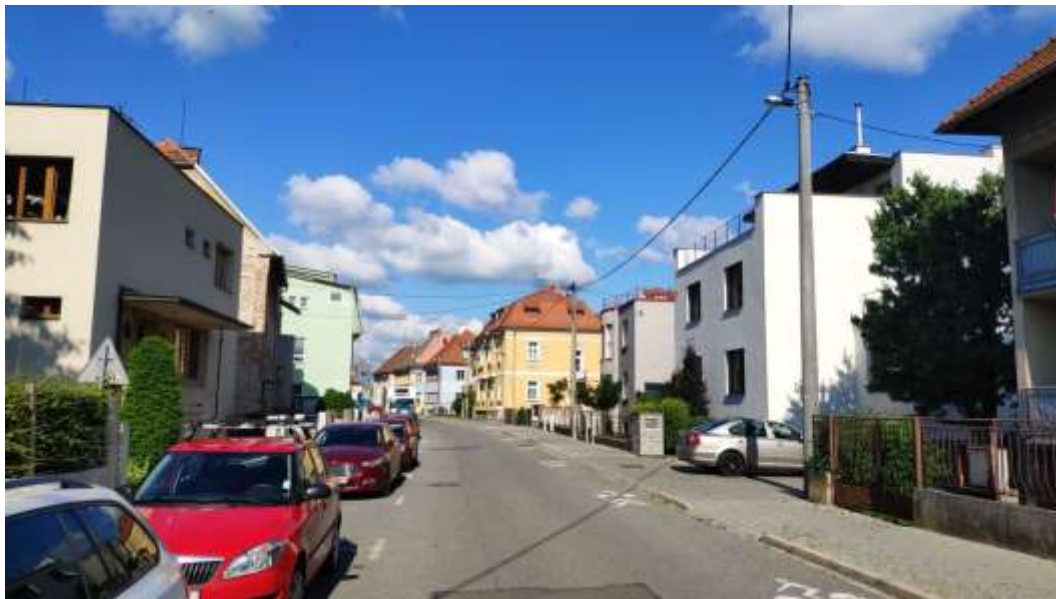
Obr. 92: Charakter VO v Kollárově ulici - svítidla jsou osazena na výložnicích ze stožárů energetických rozvodů, svítidlo bez důrazu na design.
