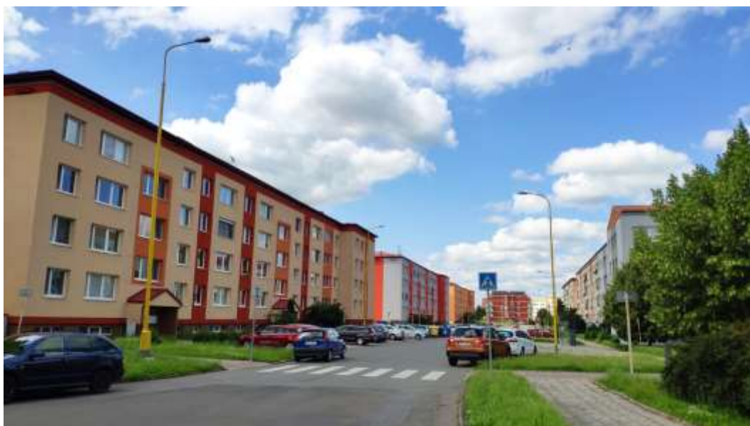
Obr. 103: Charakter VO v ulici Sadová - světelné zdroje na vysokých stožárech s nástavcem.
