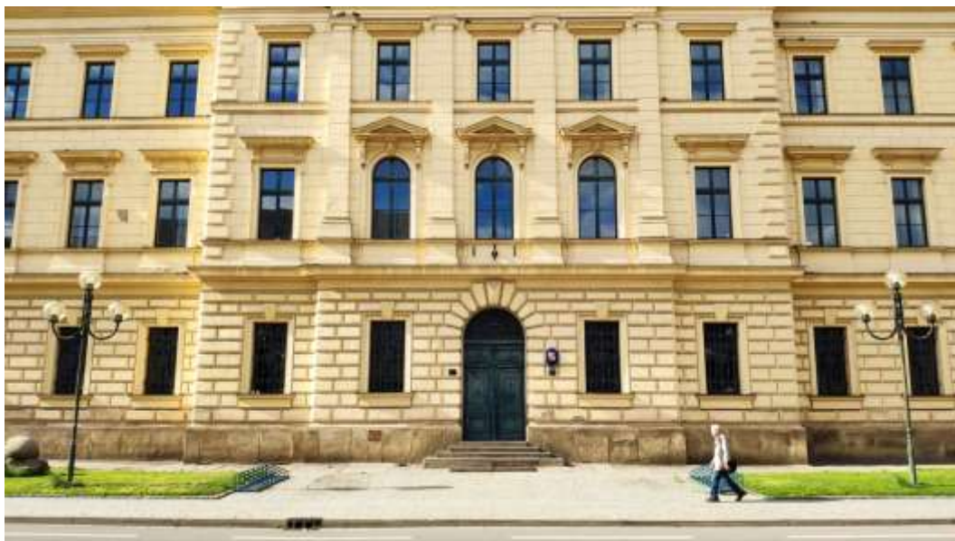
Obr. 84: Veřejné osvětlení ve Všehrdově ulici před bývalým Justičním palácem. Kulová svítidla, odstupňovaný stožár.
