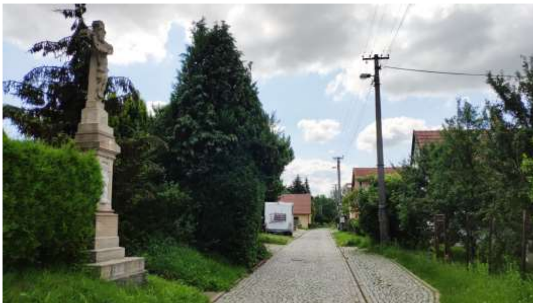
Obr. 111: Charakter VO v ulici Vinohradská - svítidla jsou osazená na výložnicích ze stožárů energetických rozvodů.
