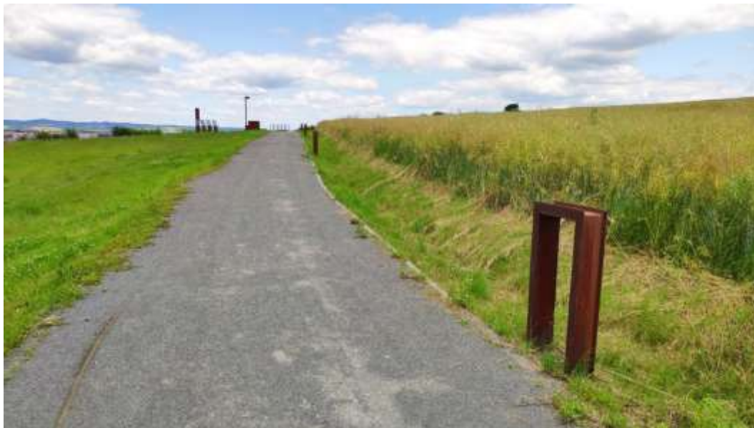
Obr. 124: Charakter VO přístupové komunikace na Výšinu sv. Metoděje. Prvky veřejného osvětlení – bollardy z cortenového plechu.
