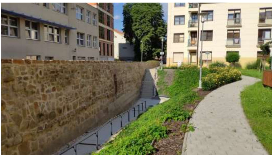
Obr. 83: Charakter VO v místě odhaleného hradebního zdiva v Kollárově ulici. Válcová svítidla s cylindry, odstupňovaný stožár.
