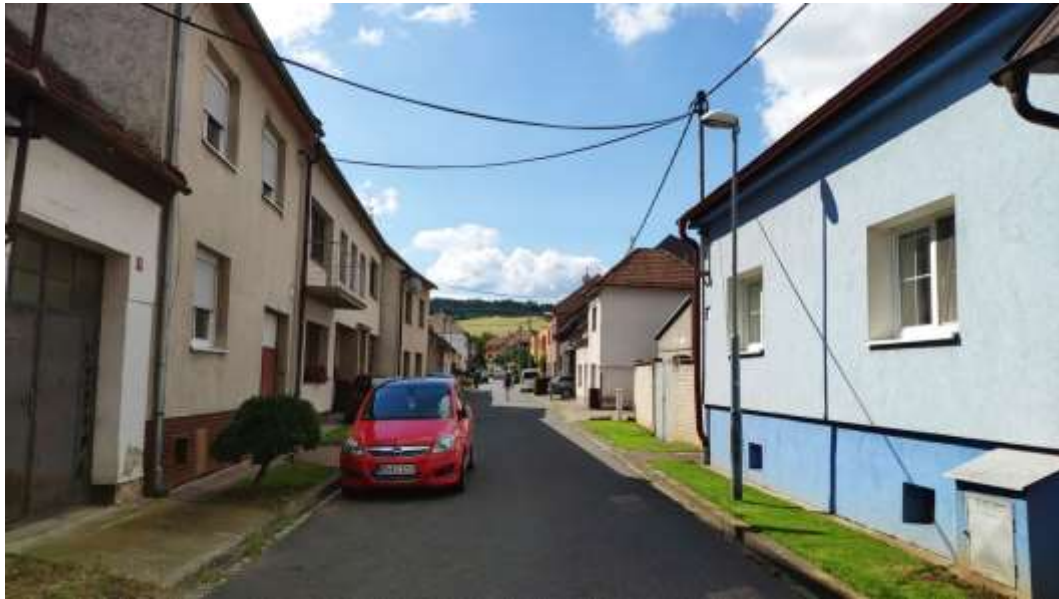
Obr. 114: Osvětlení uličního prostoru samostatnými svítidly na stupňovitých stožárech, svítidlo bez důrazu na jeho design.
