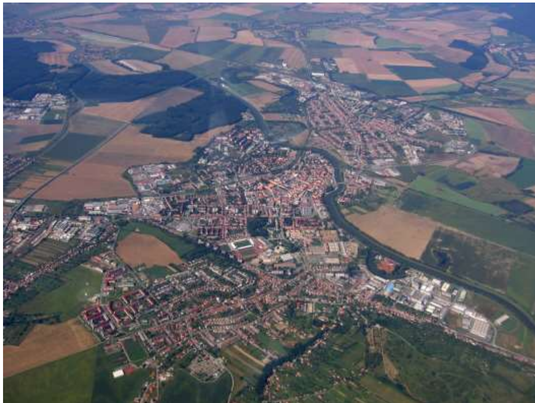
Obr. 10: Současná podoba města Uherské Hradiště – letecká fotografie.
