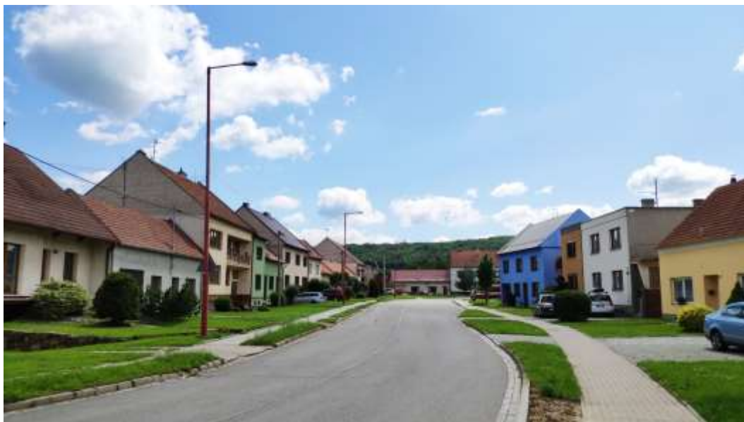
Obr. 130: Charakter VO v ulici Na Příkopě – silnice III/05014 – světelné zdroje na vysokých stožárech s výložníkem.
