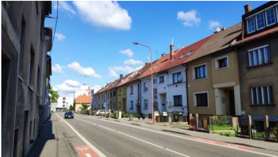
Obr. 86: Charakter VO v Svatoplukově ulici - světelné zdroje na vysokých stožárech s nástavcem.
