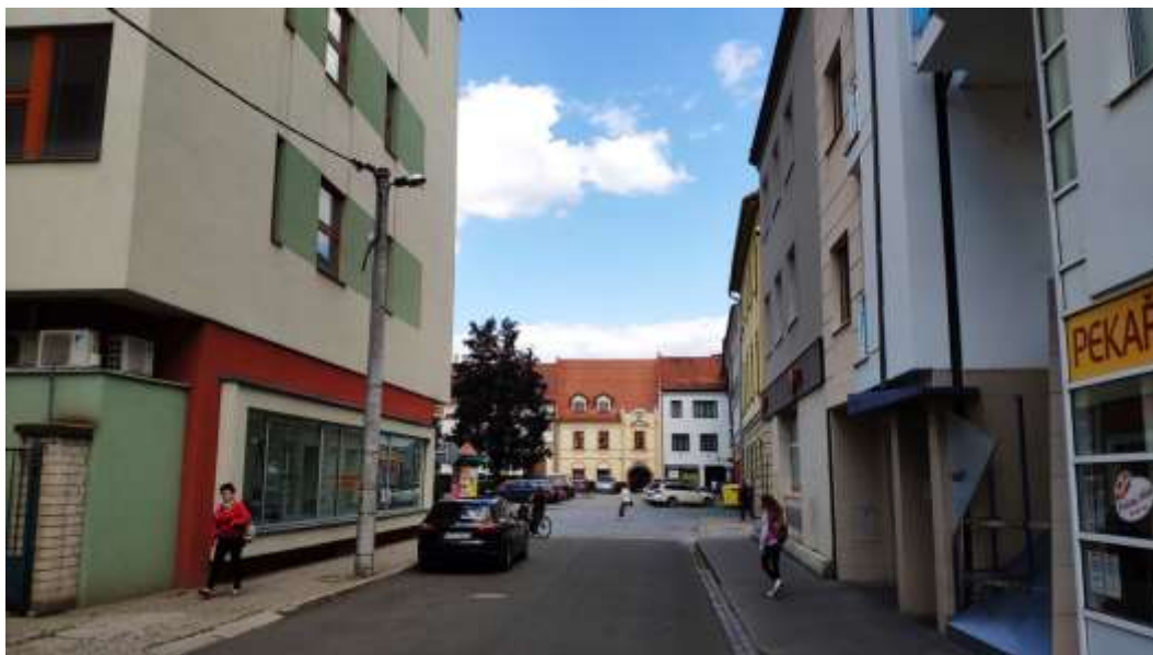
Obr. 82: Příklad svítidla osazeného na výložníku ze stožáru energetických rozvodů v centru města – ulice Na Splávku. Svítidlo bez důrazu na design.
