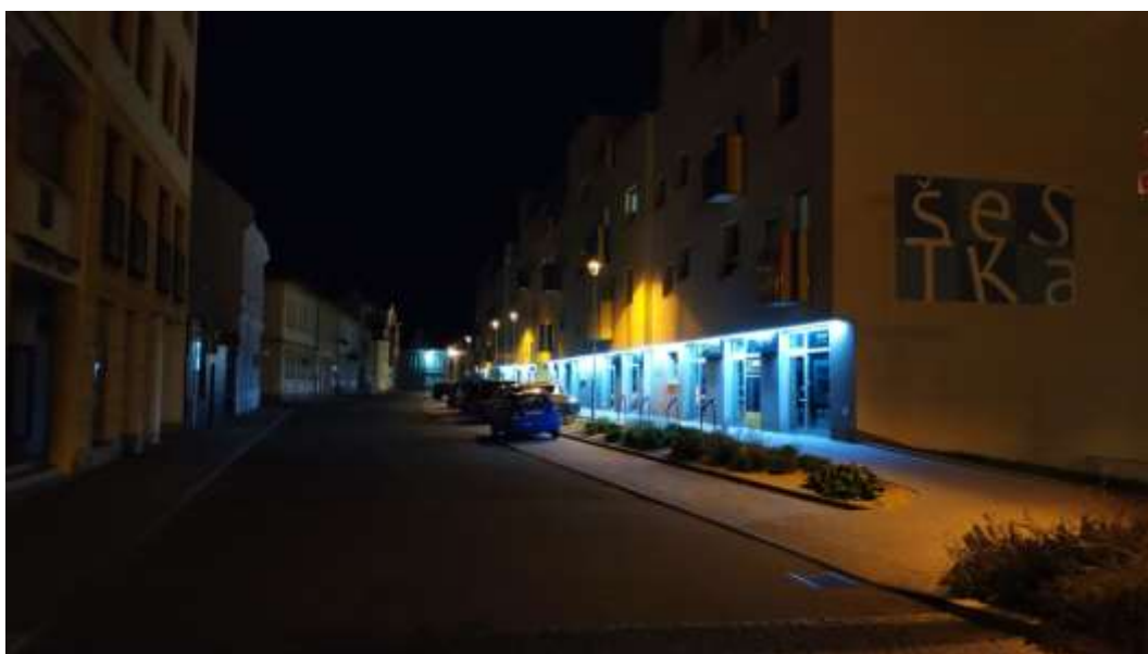
Obr. 81: Příklad nevhodného řešení osvětlení parteru objektu. Osvětlení objektu je příliš intenzivní a má nevhodnou teplotu chromatičnosti – ve vztahu k základnímu osvětlení uličního prostoru. Lepším řešením by v tomto případě bylo prosvětlení výloh komerčních ploch méně intenzivním světlem obdobné teploty chromatičnosti jako základní osvětlení.
