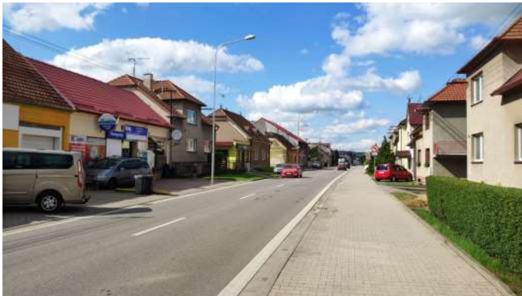
Obr. 112: Charakter VO v ulici Sokolovská – silnice II/497 – světelné zdroje na vysokých stožárech s nástavcem.
