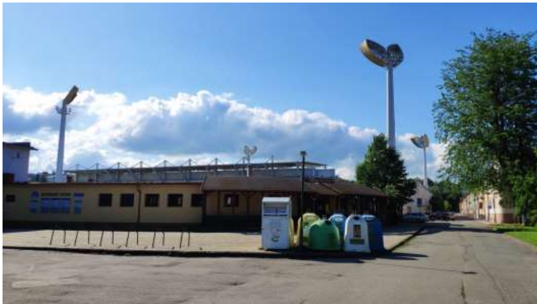
Obr. 23: Způsob řešení osvětlení hrací plochy fotbalového stadionu.
