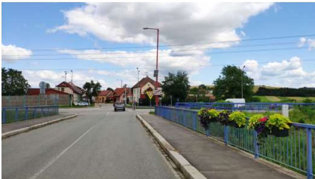
Obr. 127: Charakter VO úseku silnice I/50 – světelné zdroje na vysokých stožárech s dvojitým nástavcem.
