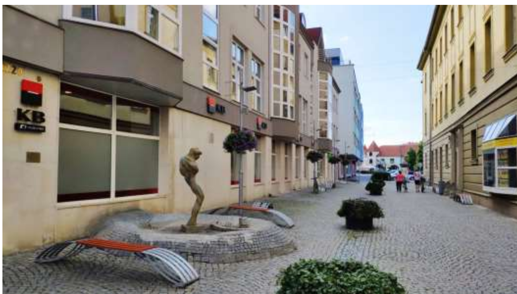
Obr. 77: Řešení veřejného osvětlení pěší komunikace v Protzkarově ulici. Nepřímé osvětlení, svítidla s odraznou deskou. Odstupňovaný stožár bez patice.
