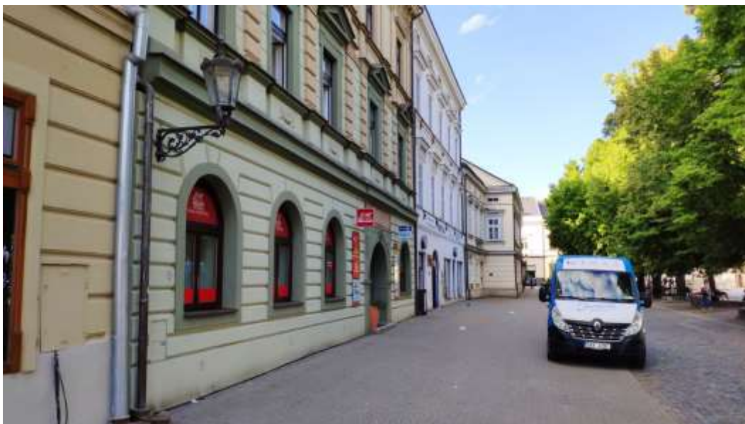
Obr. 70: Historické/historizující lucerny na konzolách na fasádách domů na severozápadní straně Masarykova náměstí.
