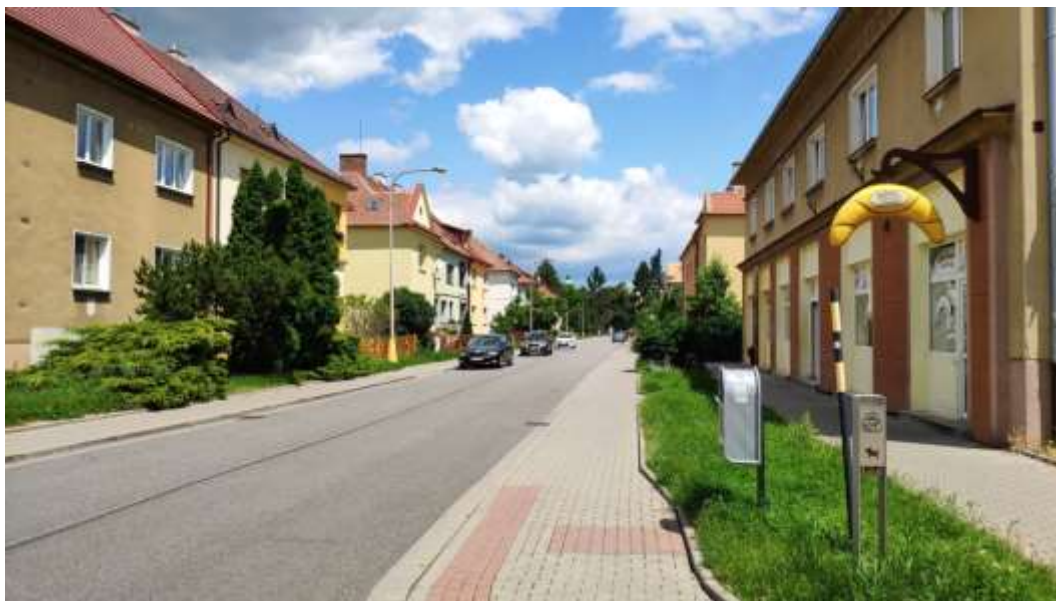
Obr. 93: Charakter VO na sídlišti Mojmír I v Husově ulici - světelné zdroje na vysokých stožárech s nástavcem, svítidlo bez důrazu na design.
