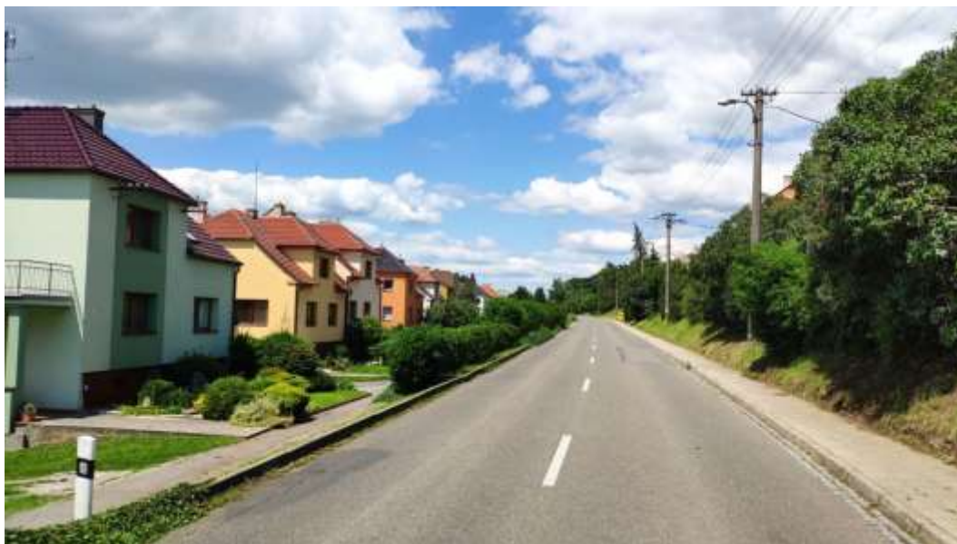
Obr. 120: Charakter VO v ulici Solná cesta - svítidla jsou osazená na výložnicích ze stožárů energetických rozvodů.
