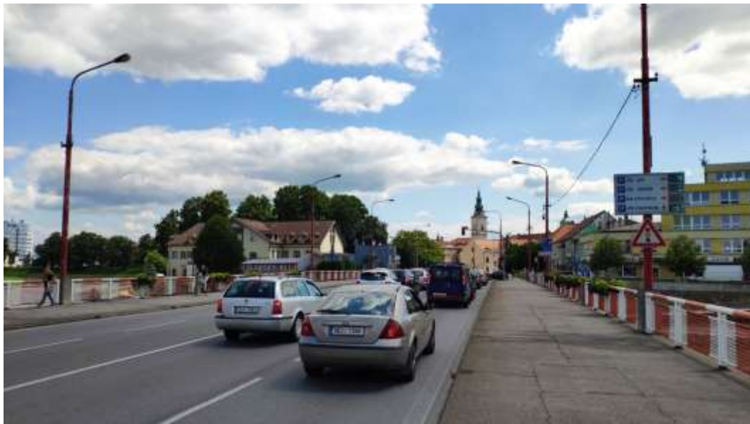
Obr. 89: Pohled přes silniční most přes řeku Moravu na charakter VO na Velehradské třídě (silnice I/55) - světelné zdroje na vysokých stožárech s nástavcem. Svítidlo a stožár bez důrazu na design.
