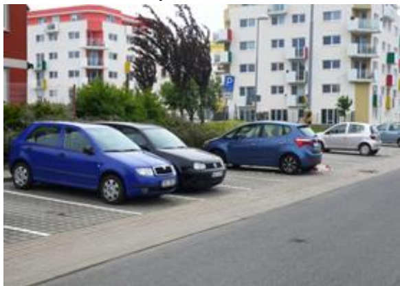
Obrázek: Parkovací stání s propustným povrchem u O-City, Uherské Hradiště
