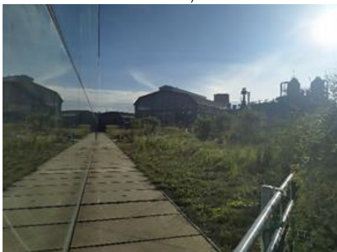
Obrázek: Zelená střecha roku 2016 – STC Ostrava, Dolní Oblast Vítkovice
