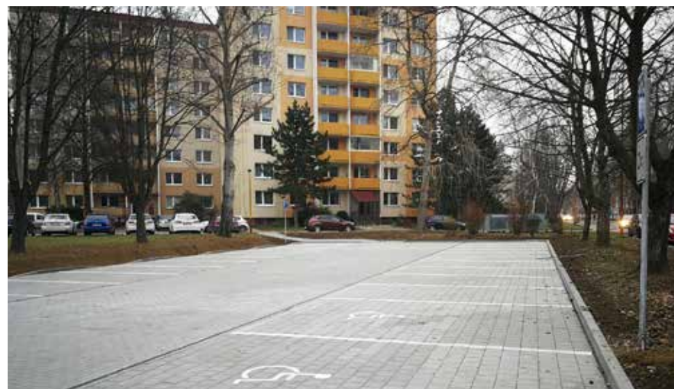
Výměna nepropustných povrchů Štěpnice – I. etapa
