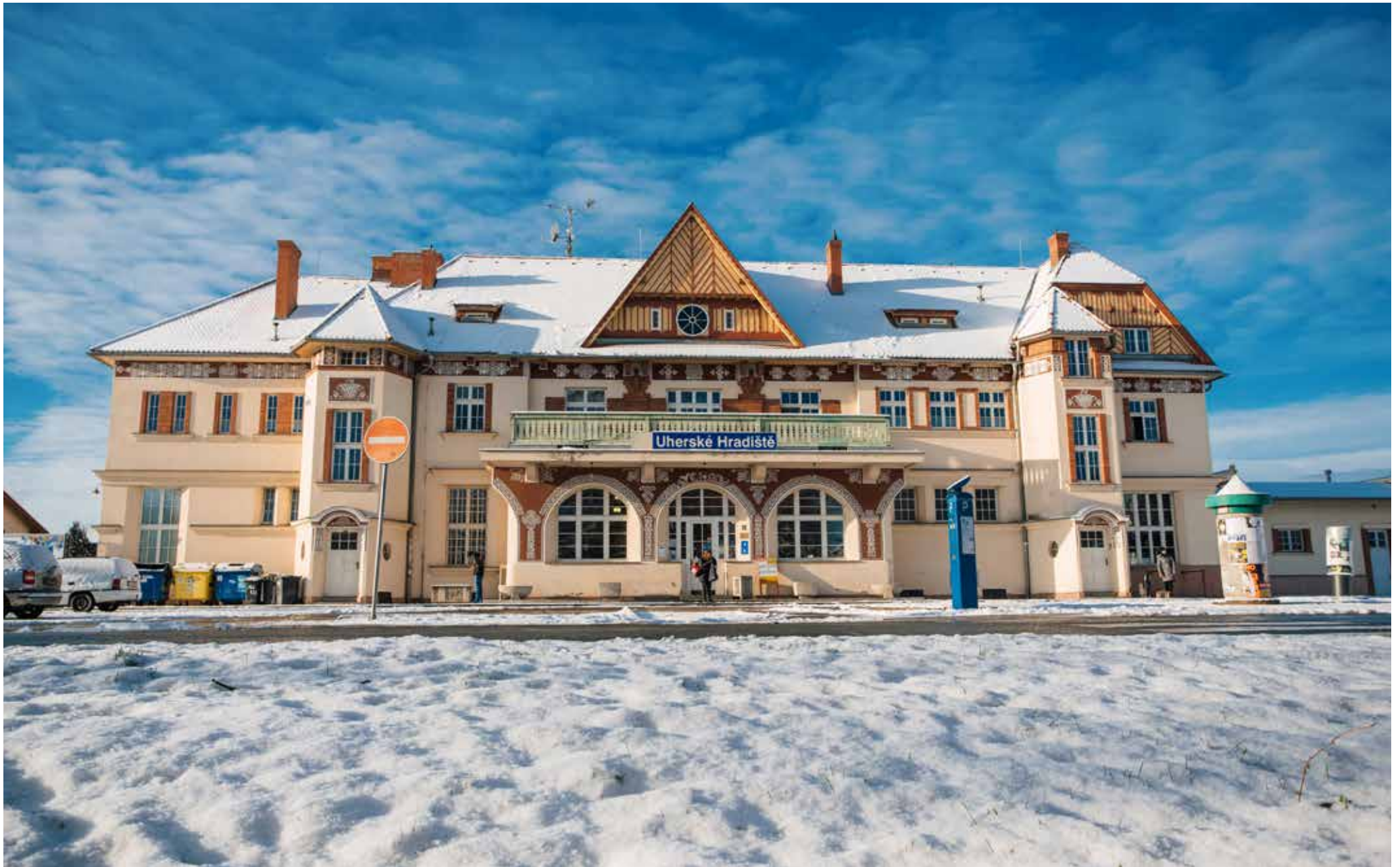
Vlakové nádraží Uherské Hradiště
