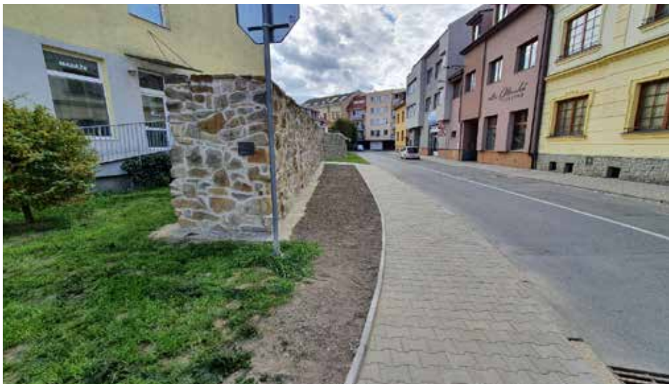
Obnova městských hradeb, ul. Dlouhá II. etapa
