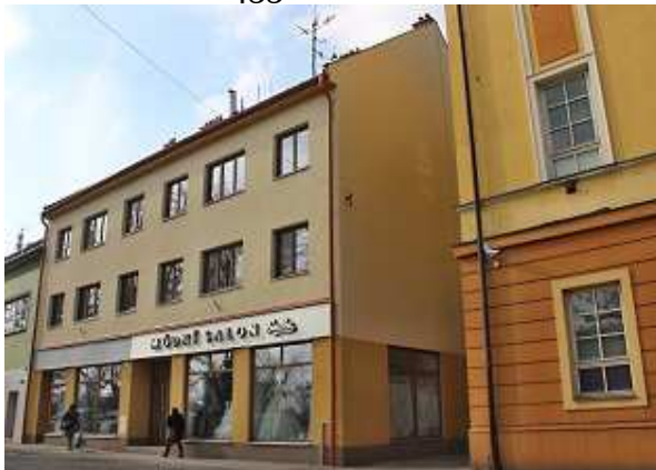
Oprava fasády na objektu Nádražní 24
