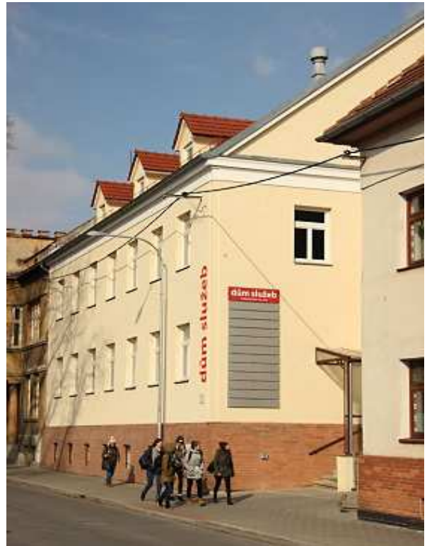
Oprava fasády na objektu
