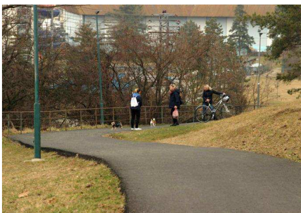
Oprava povrchu serpentin Mařatice I. etapa
