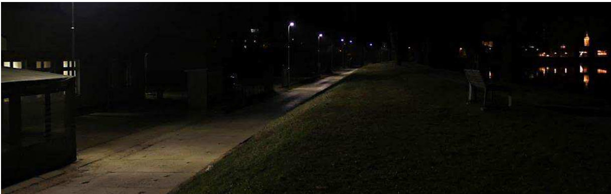
Rekonstrukce veřejného osvětlení u čp. 887-889, mezi ul. Šafaříkova a Svatováclavská, doplnění veřejného osvětlení v ul. Na Loukách, nové veřejné osvětlení v části ul. U Moravy
