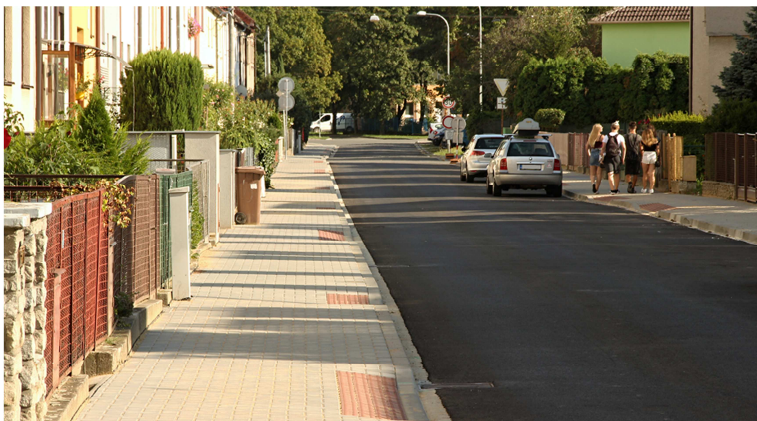
Rekonstrukce chodníků v ul. Lechova (část, součinnost s opravou vodovodu)
