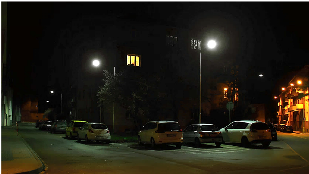
Kompletní rekonstrukce veřejného osvětlení v ul. Dukelských hrdinů
