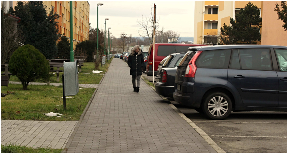
Oprava chodníku na sídlišti Louky (část)
