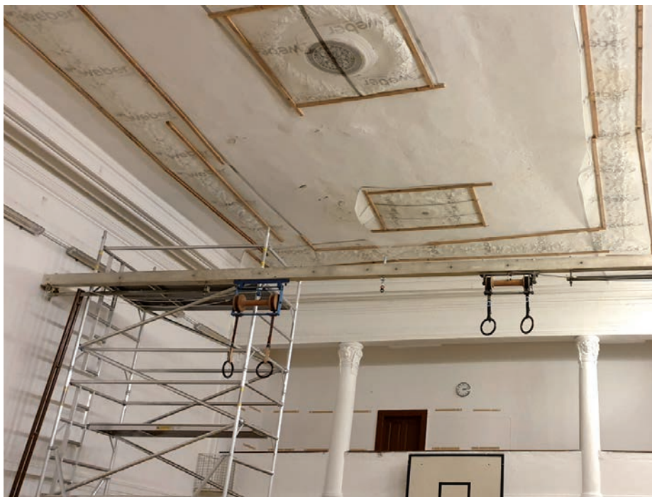
Historický štukový strop tělocvičny zůstal při rekonstrukci zachován.
