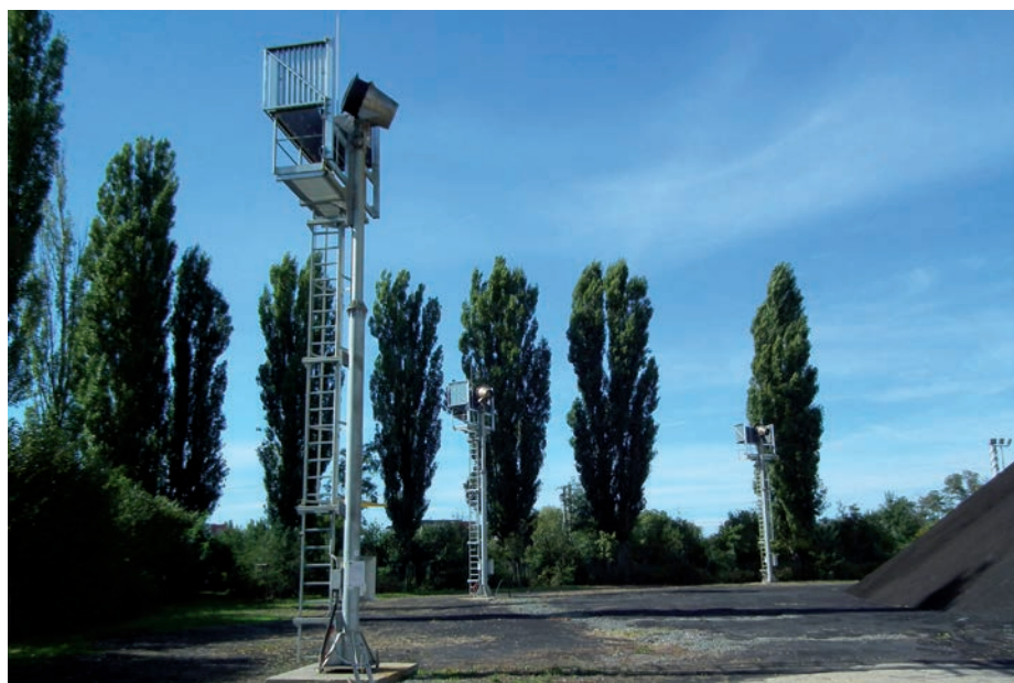
Takzvaná mlžná stěna, kterou nechala nainstalovat společnost CTZ v areálu teplárny, podle obyvatel z okolí k výraznějšímu snížení prašnosti nepřispěla. Foto: CTZ
