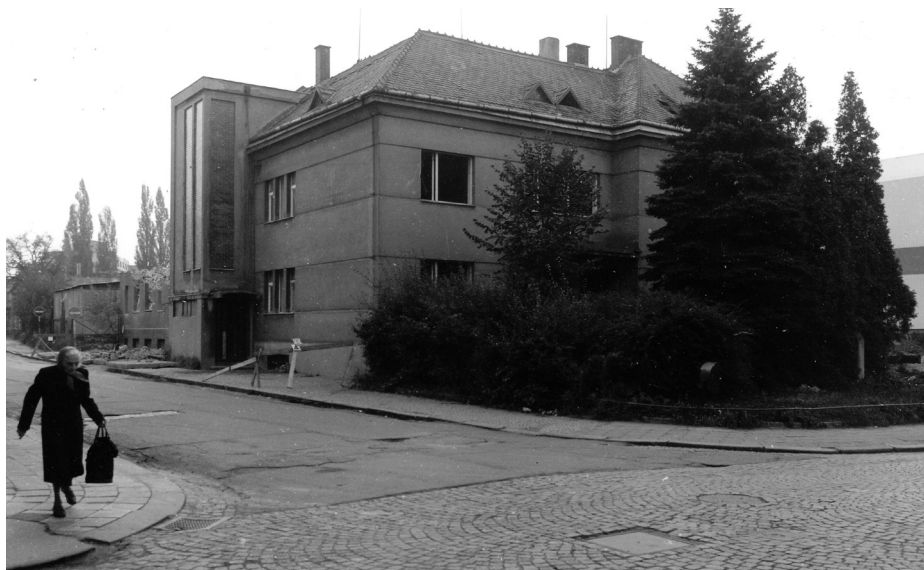
Bourání domů před Klubem kultury. Vpředu Skulův dům č. p. 555, za ním zbytek domu č. p. 188.
