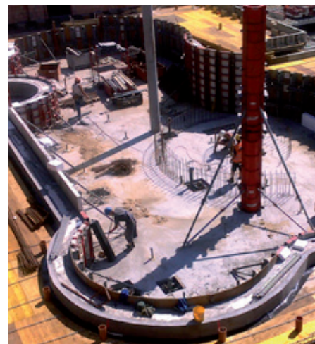
Zábavní bazén během výstavby, rok 2010.
