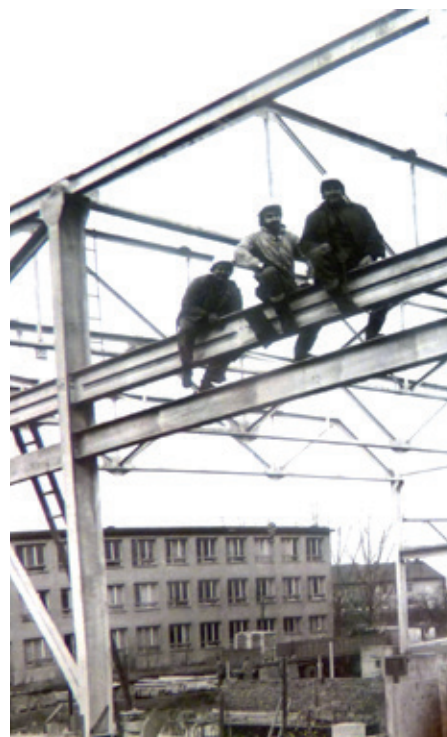
Výstavba krytého bazénu, rok 1988.
