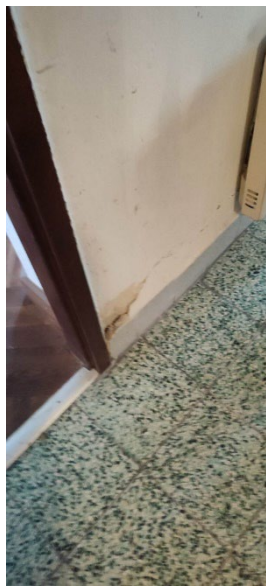
Příloha 2 – průsak v přísáli
