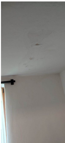
Příloha 1 – průsak v hlavním sále
