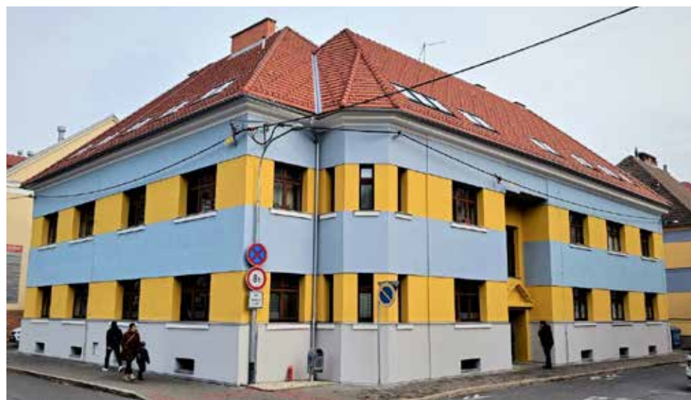
Stavební úpravy BD č. p. 403, ul. Kollárova
