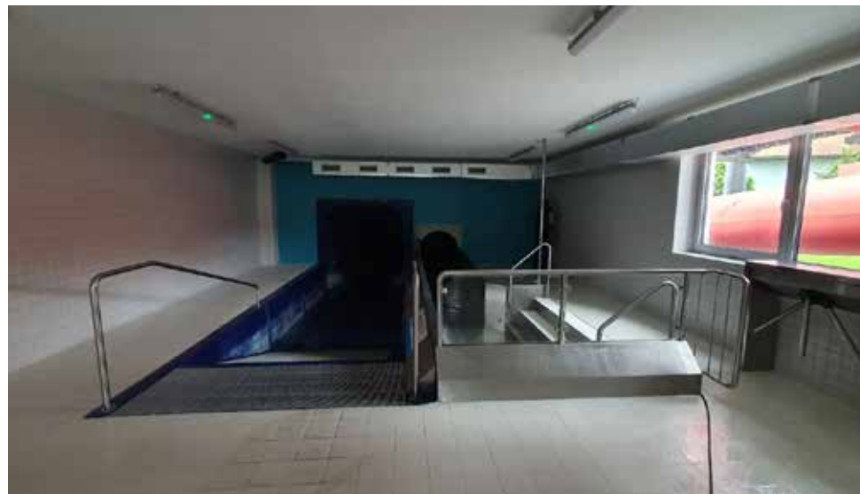
Aquapark – rekonstrukce toboganové věže
