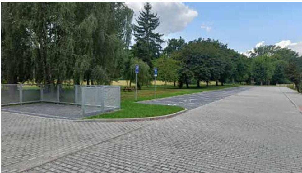
Parkování Štěpnice III – výměna nepropustných povrchů
