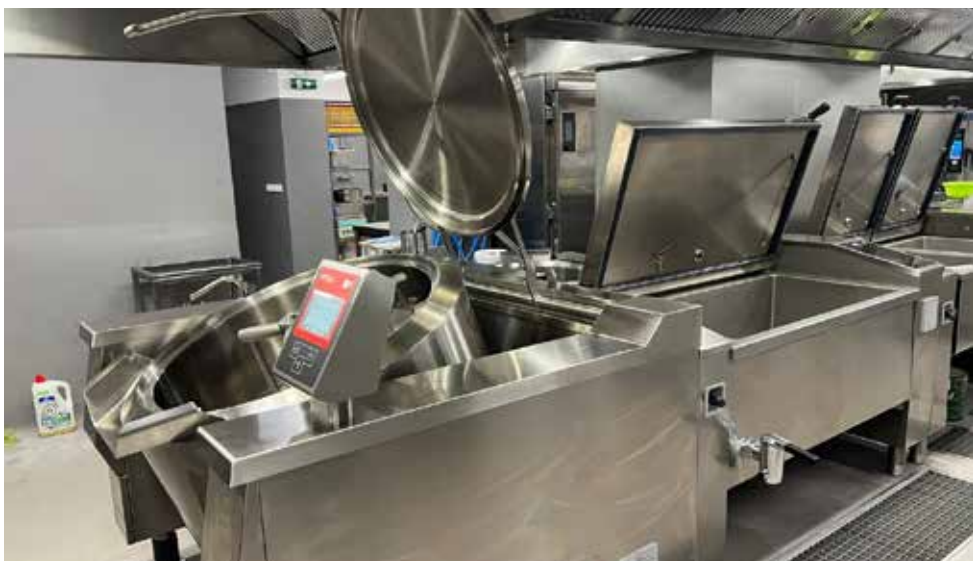
ZŠ UNESCO – rekonstrukce kuchyně a sanace vlhkosti
