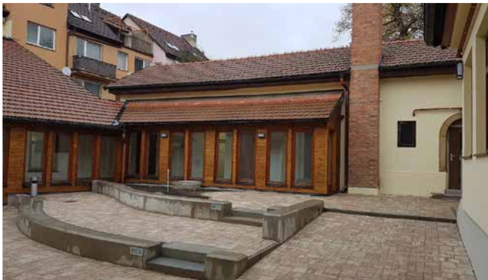
Stavební úpravy MKZ Mařatice
